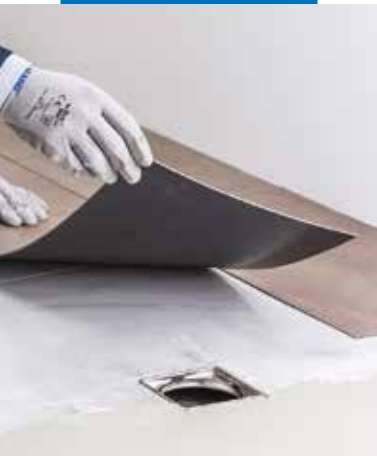
Colocación de LVT con Ultrabond Eco MS 4 LVT en ambiente húmedo
